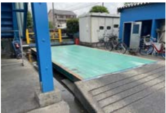
【トラックスケール】
