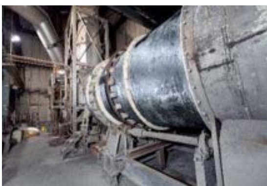
【焼却施設〈トロンメル〉】
