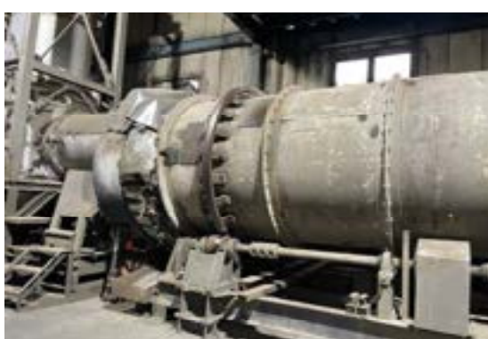
【焼却施設〈トロンメル〉】
